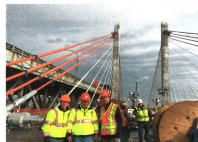
Most Kościuszki w Nowym Yorku w budowie 2017 r.
